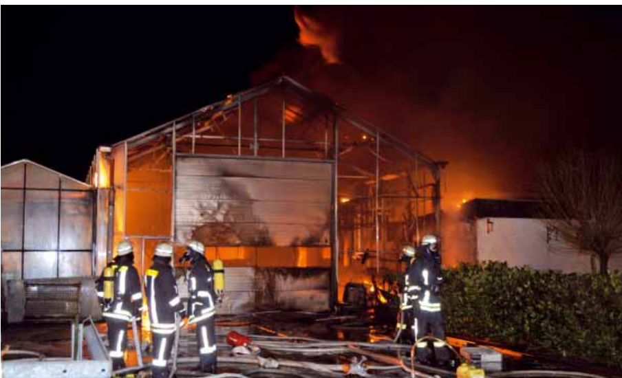
Großbrand in Westfalen verursacht Schäden in Millionenhöhe. Neben direkten Schäden entstanden auch erhebliche Verluste durch reine Rußbeaufschlagung an den Kulturen.
