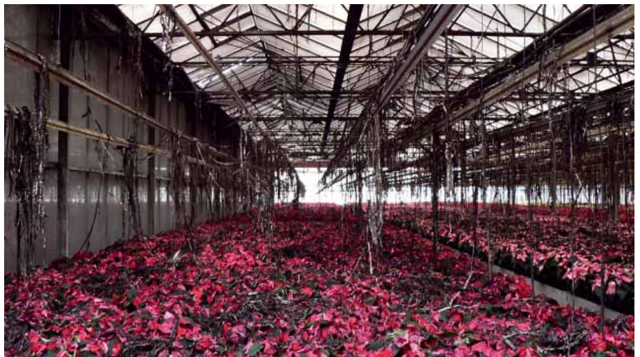
Großbrand in Westfalen: In kürzester Zeit konnte sich das Feuer über die leicht entflammbaren Schirme und das brennend herabtropfende Schirmmaterial verbreiten.
