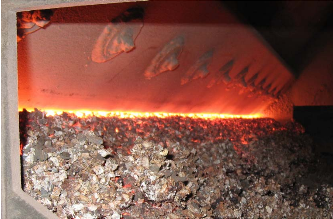
Kühlbrücke / Wassertasche in einem Füllschachtkessel
