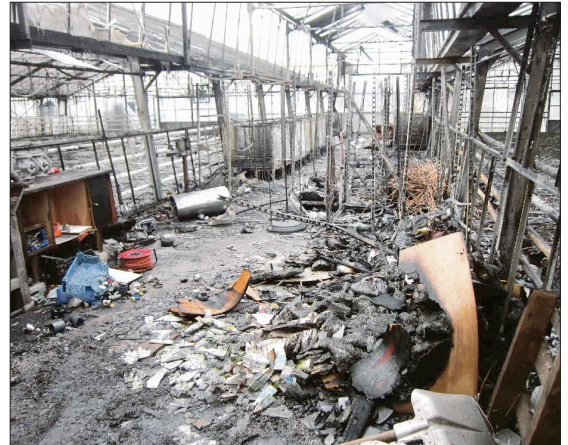
Ausgehend von einer in Brand geratenen Assimilationslampe fingen darüber befindliche Schirmtücher aus B3-Material Feuer. Das Feuer konnte sich hierdurch auf weitere Häuser rasch ausbreiten; versicherter Schaden 500.000 Euro. Fotos: GV
