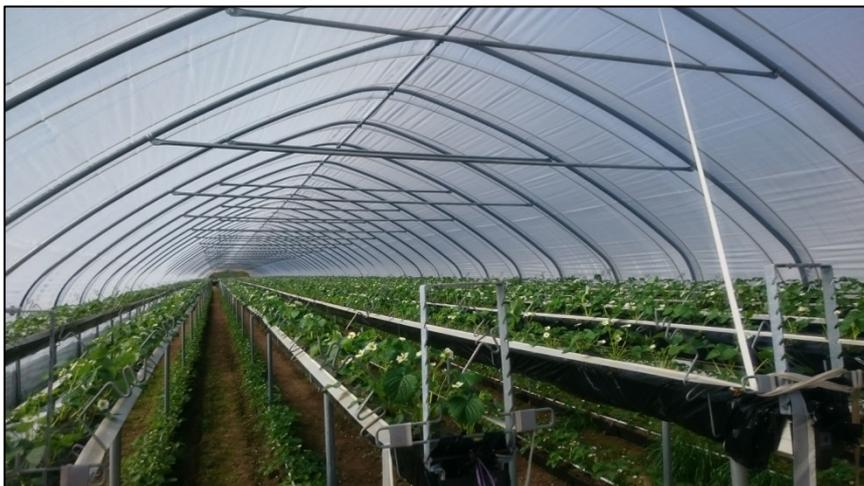
**Foto 2: Einfacher Folientunnel mit durchgehendem First und Unterzügen in den Bögen.**
