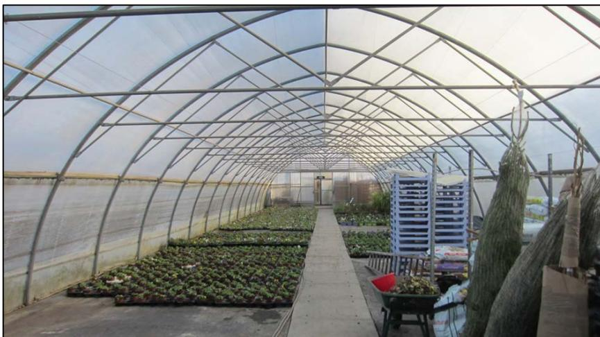
**Foto 1: Einschiffiges Folinhaus mit Firstrohr, Unterzügen und Bogenaussteifung.**
