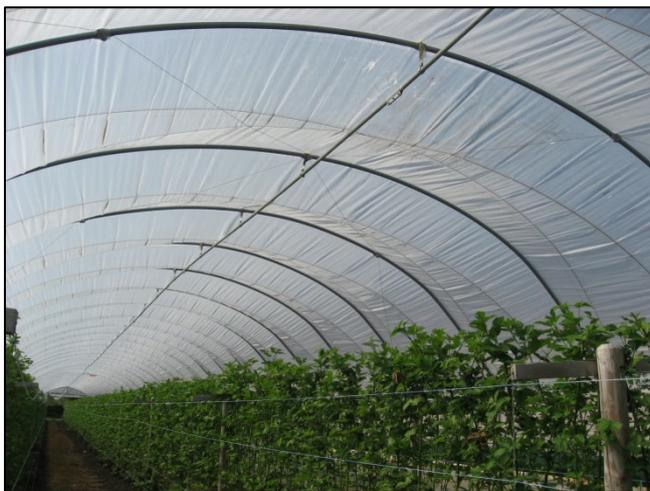
**Foto 3: Nicht versicherbarer Folientunnel mit abgehangenem First und ohne Unterzüge. (Fotos: GV)**
