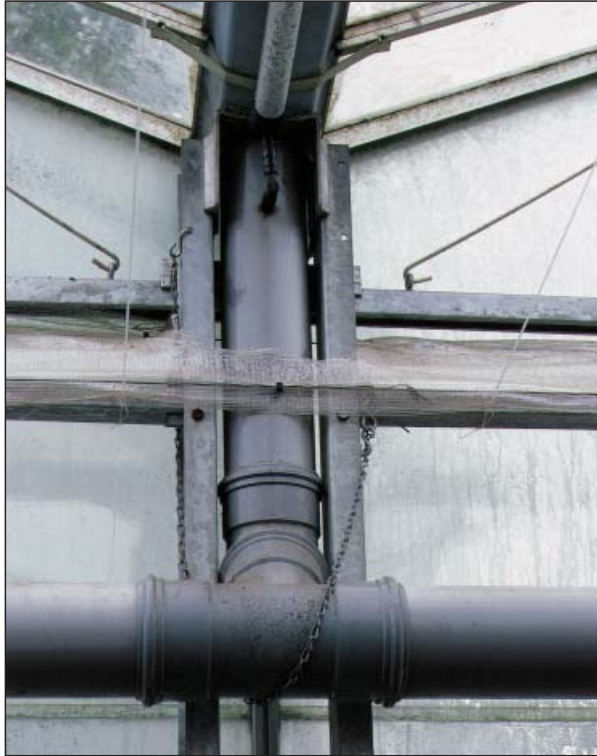
▲ Abbildung 4: Ein längeres Fallrohr bietet mehr Sicherheit. Es ist auch realisierbar, wenn der Sammler eine gewisse Aufhängehöhe haben muß.
