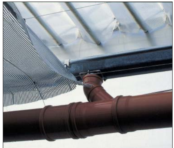
▼ Abbildung 5: Dieser Sammler erhielt mit jeder einmündenden Rinne einen größeren Durchmesser.
