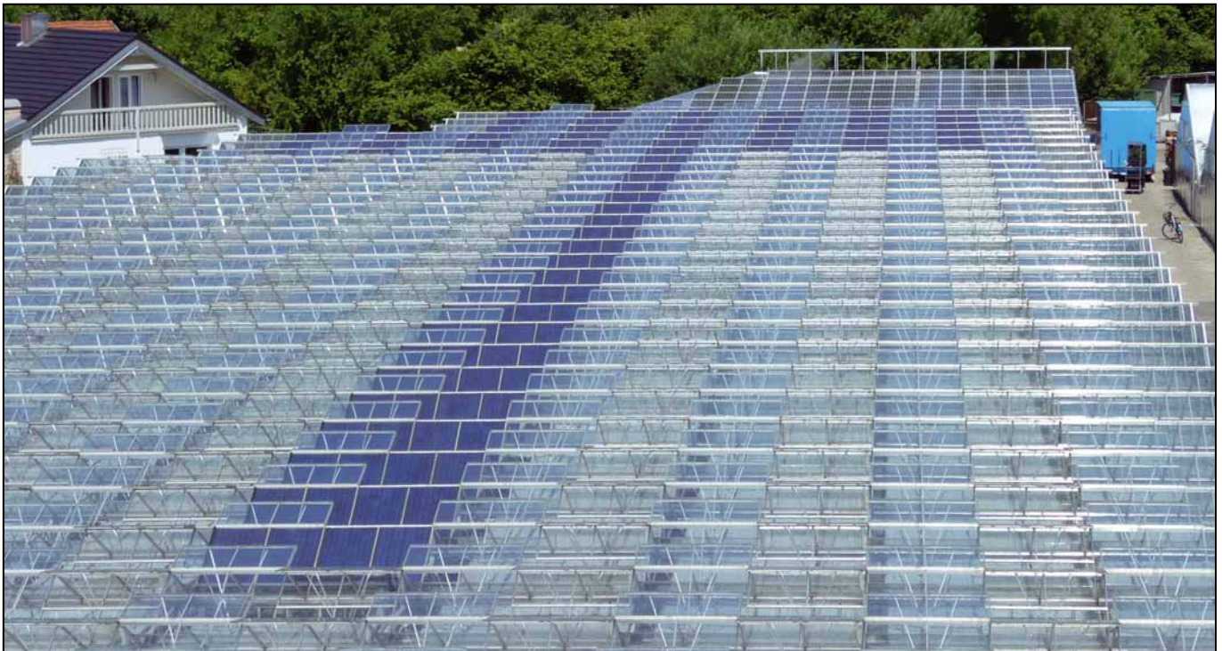
Bild 1: PV-Module eingelegt über Gehweg und Arbeitshalle
