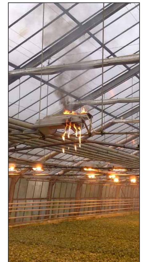
Bild 2: Entstehungsbrand an alter Assimilationslampe. Gut sichtbar: das brennende Abtropfen des Kunststoffgehäuses.
