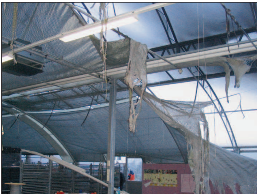
Bild 1: Positive Wirkung eines schwerentflammbaren Schattiergewebes unter Einscheibensicherheitsglas (ESG).
