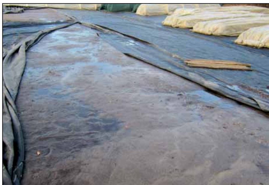
Bild 2: Rinnen- und Senkenbildung unter der Gewebefolie
